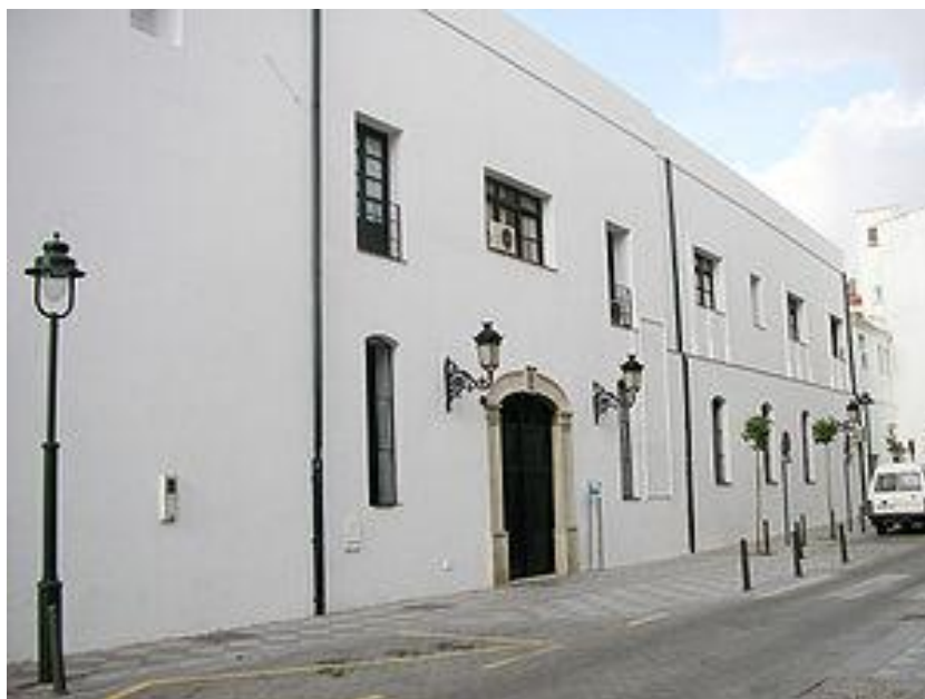
Ilustración 7, Fachada exterior del Hospital de la Caridad, actualidad
